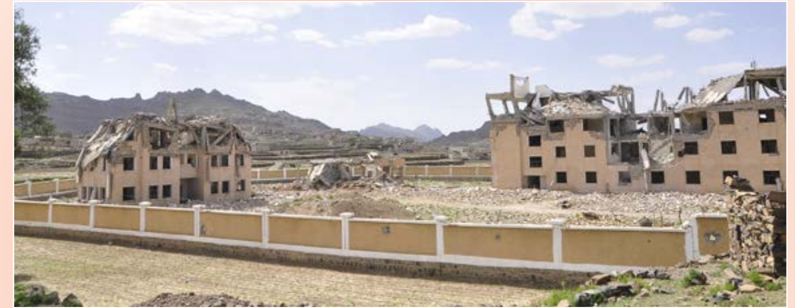
تدمير مبنى محكمة استئناف صعدة ٢٠١٥/٥/٤ م destroying Saadah appeal court, 4/5/2015
